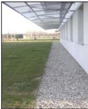
▶ Tranchées sous toit
