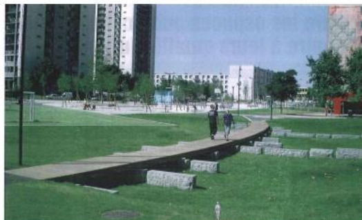
Bassin tampon paysager
