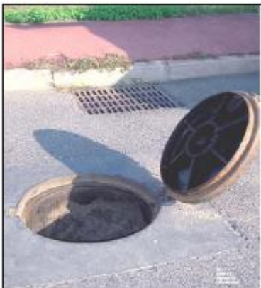
► Puits d'infiltration sur voirie (à éviter)
